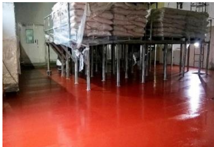
ユークリート® UD200を施工した砂糖投入エリア
