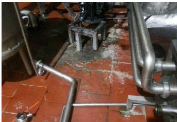
ユークリート施工前の床の状態
